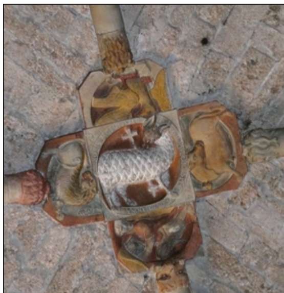
Clef de voûte au monastère de Chalais
