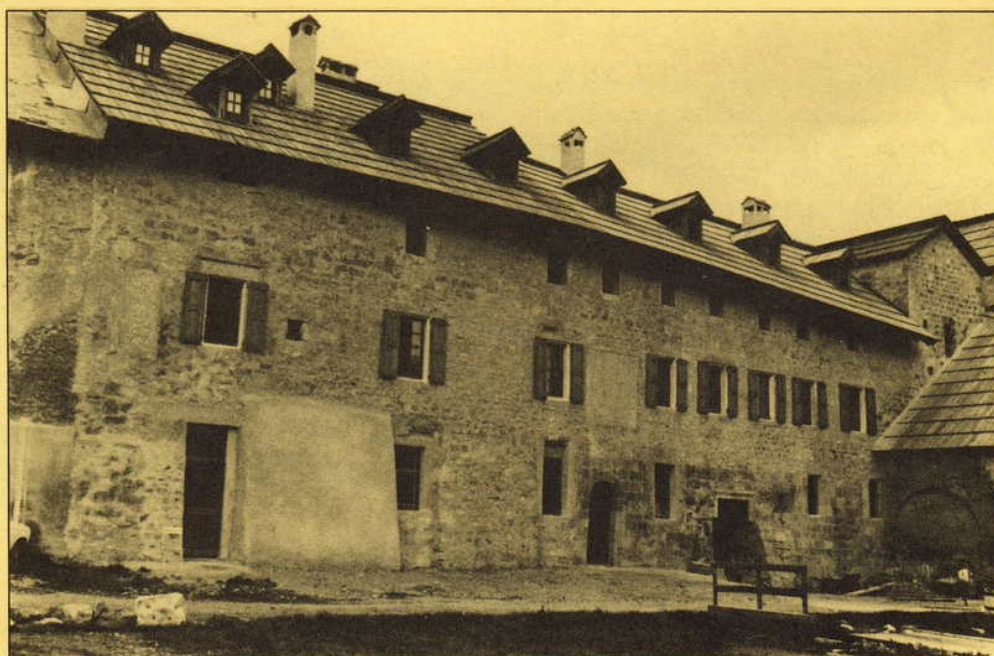
Résultat de la tranche de travaux (1983-1987) qui sera réceptionnée le 4 avril 1988.
