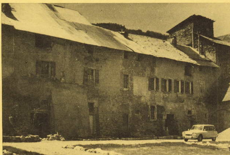
Aile des moines, façade Est, photos prises en 1977 et en 1987.
