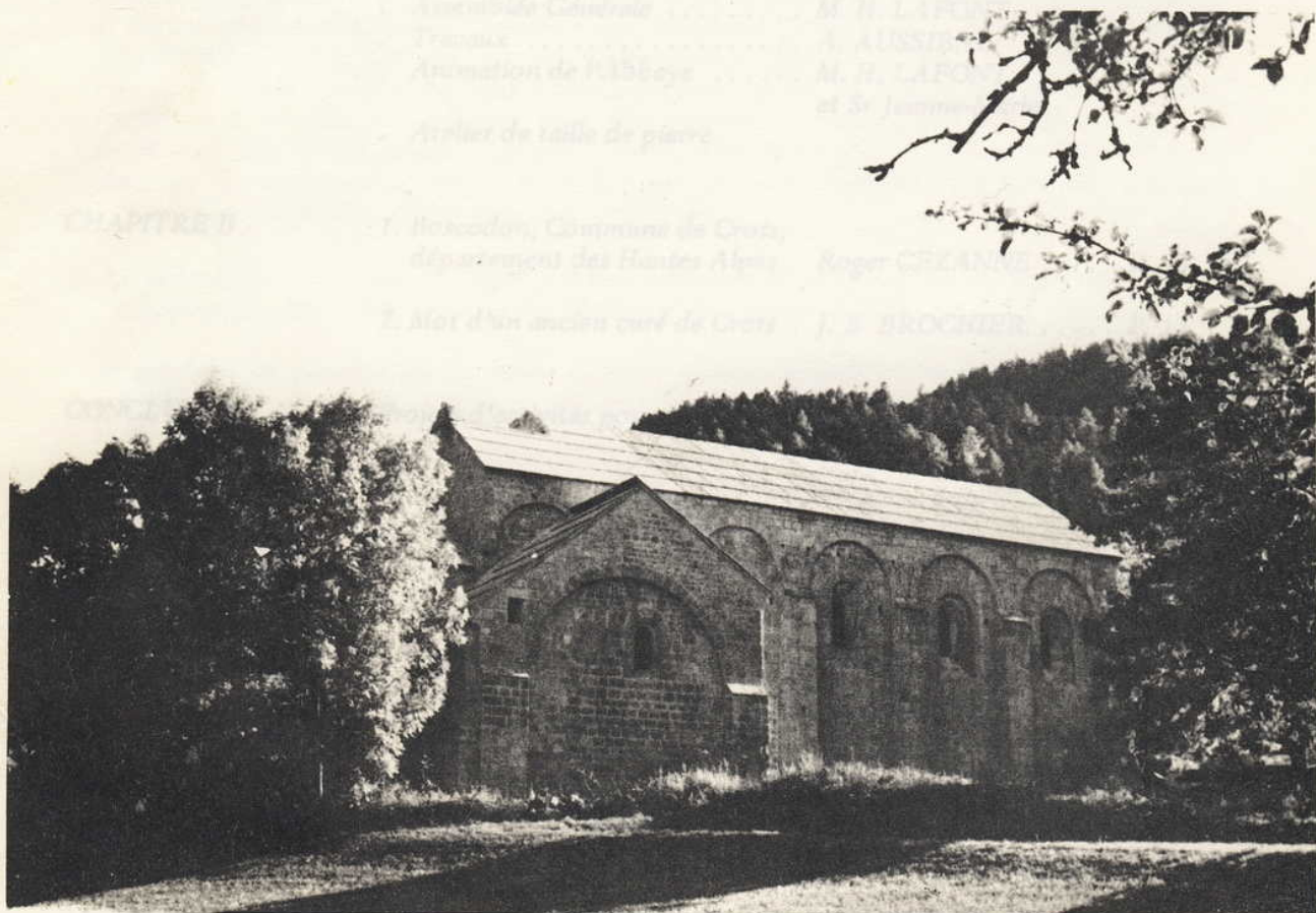
Abbatiale, façade Nord après restauration des couvertures et des maçonneries Septembre 1979
